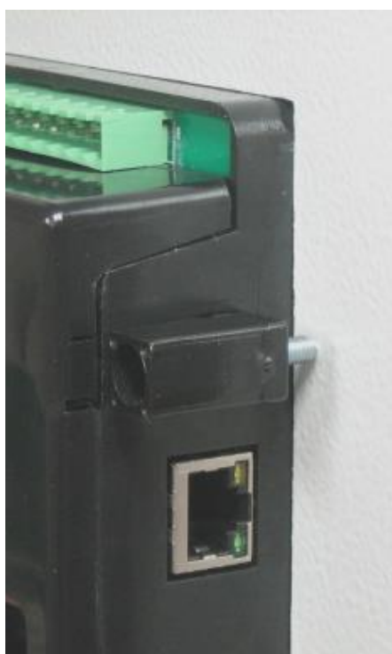
Instalação do suporte do tipo parafuso
